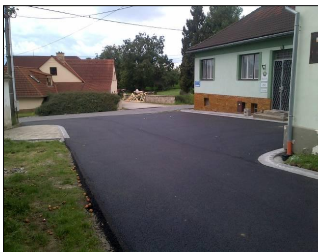
Nový asfaltový povrch před obecním úřadem
