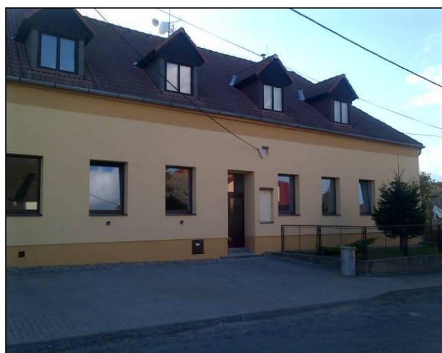
Nová fasáda bývalé školy
