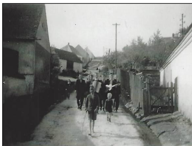
Místní komunikace „na kopec“ dříve
