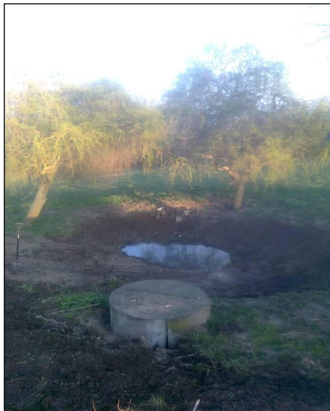
Rybníček Důlka – pohled na studnu před čištěním
