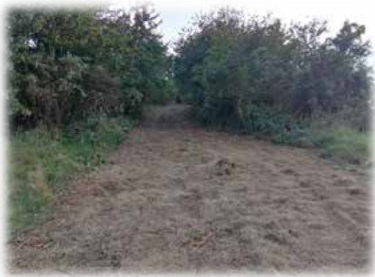
Část cesty po vyčištění
